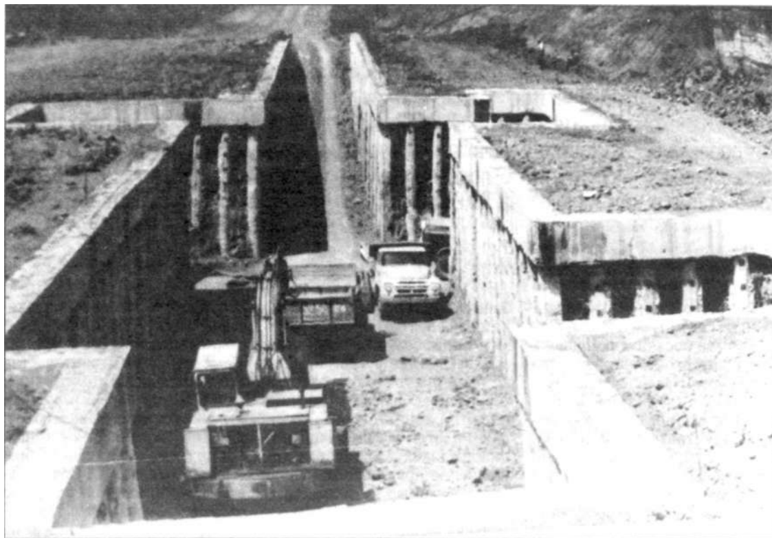
Конец 60-х годов. Строительство вагоноопрокидывателя на ТЭЦ-2
