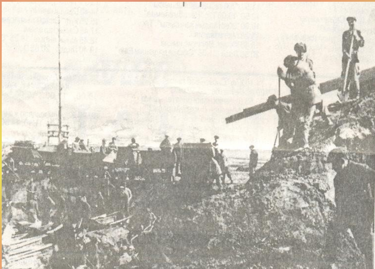
Строительство Казахского металлургического завода
